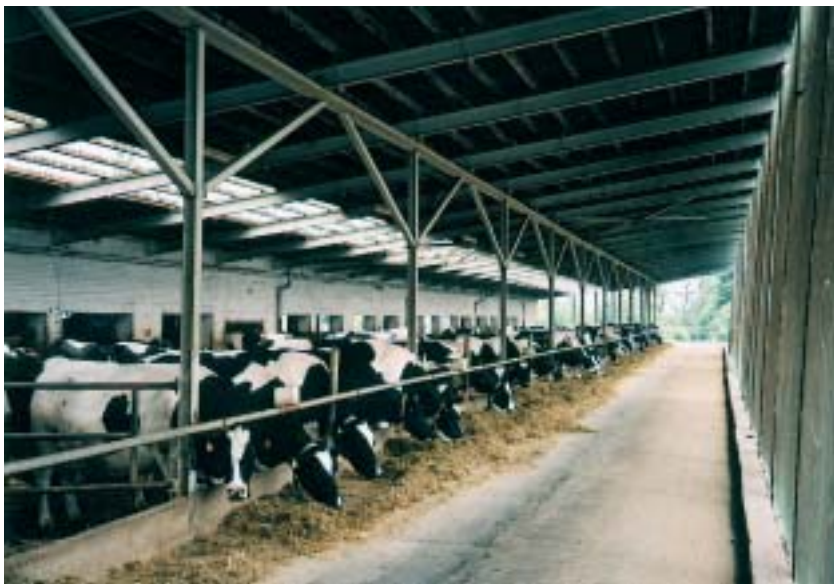
Korytarz i stół paszowy. Widoczny jest również nowoczesny ekran z drobnej siatki, świetliki i wejście do obory
